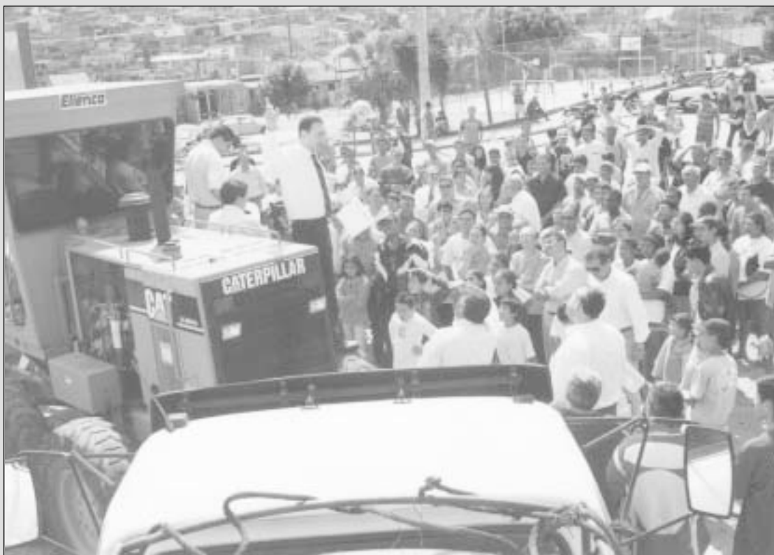
Secretários, vereadores e dezenas de moradores acompanharam o início das obras
